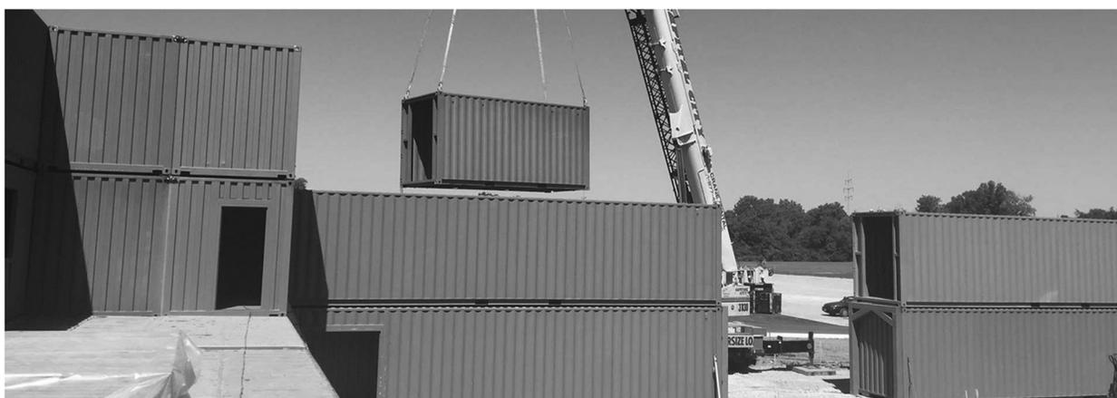
**Рисунок 2. Процесс монтажа контейнеров**
