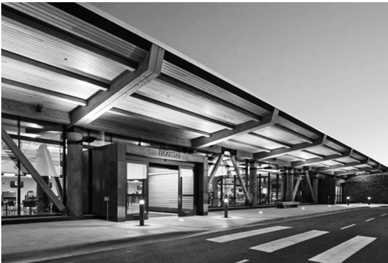
Рисунок 4. Аэропорт Джексон-Хоул Figure 4. Jackson Hole Airport
