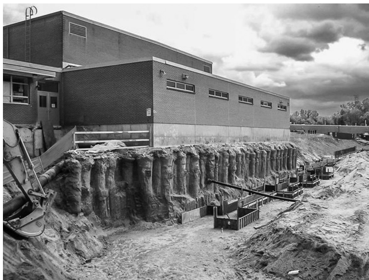
Рисунок 3. Подпорная стенка из грунтоцементных свай
