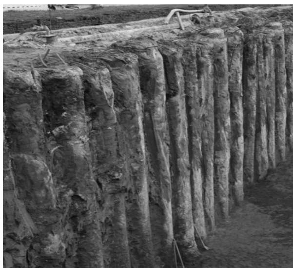
Рисунок 2. Подпорная стенка из буросекущих свай
