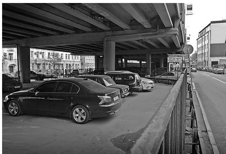
Рисунок 5. Парковки под городскими эстакадами
